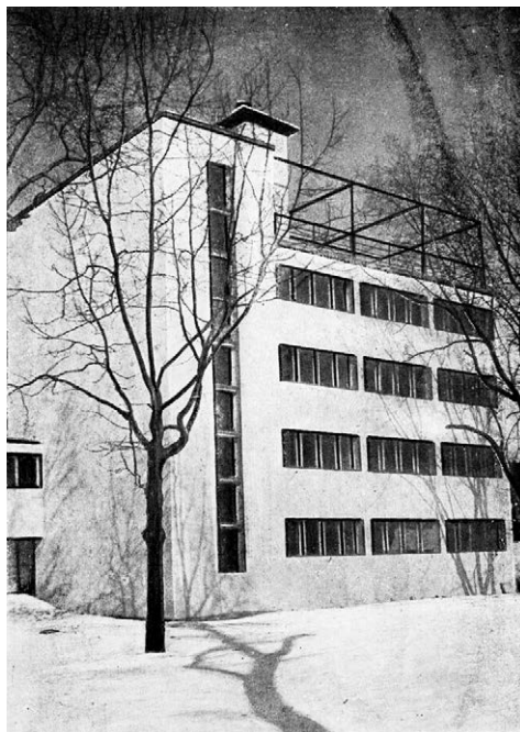
► Figs. 384-385. Fachadas norte (izquierda) y sur (derecha) del edificio comunitario de la Casa Narkomfin a comienzos de la década de 1930.
