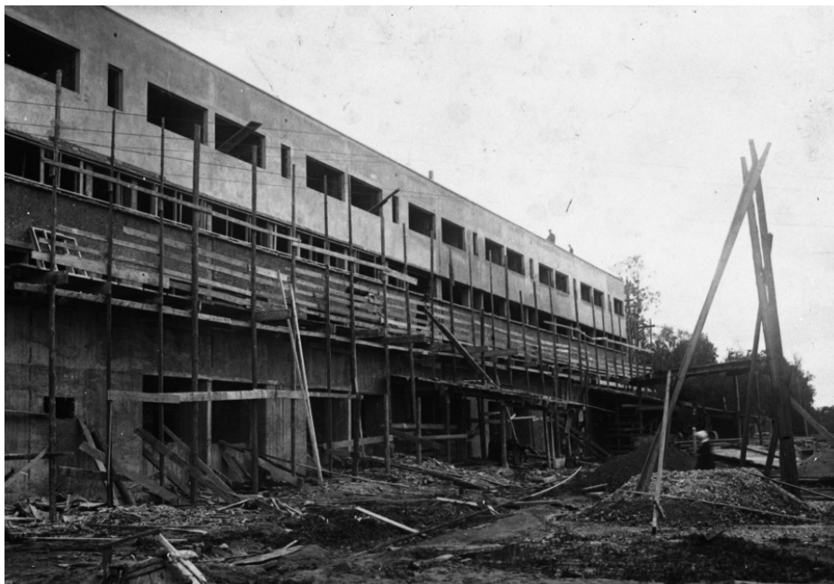
► Fig. 321. Casa del Instituto Estatal de Veterinaria Experimental construida por el Stroykom. Fotografía de la construcción del edificio, c. 1930.
